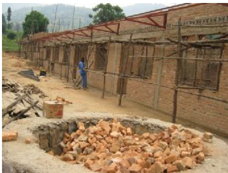
Baufortschritt bis Mitte Februar im Vordergrund der Sockel für eine Zisterne
