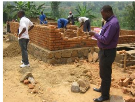
Bau des Latrinblocks mit 10 Kabinen
